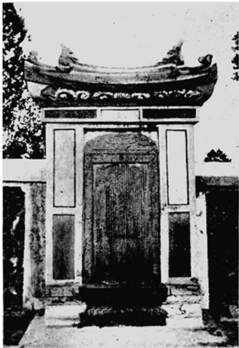
Planche CXLIV. — La Grande stèle à droite et à gauche ; stèles placée en 1815 lors de la réparation du tombeau
